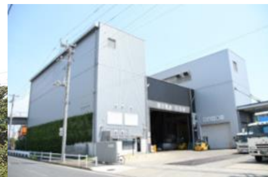
エコプラント江東：破砕、切断、圧縮梱包施設
