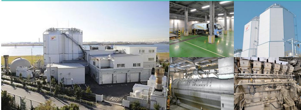
城南島工場：食品廃棄物リサイクル施設（メタン発酵バイオガス化プラント）
